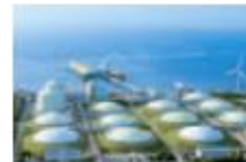
Sodegaura LNG Terminal
